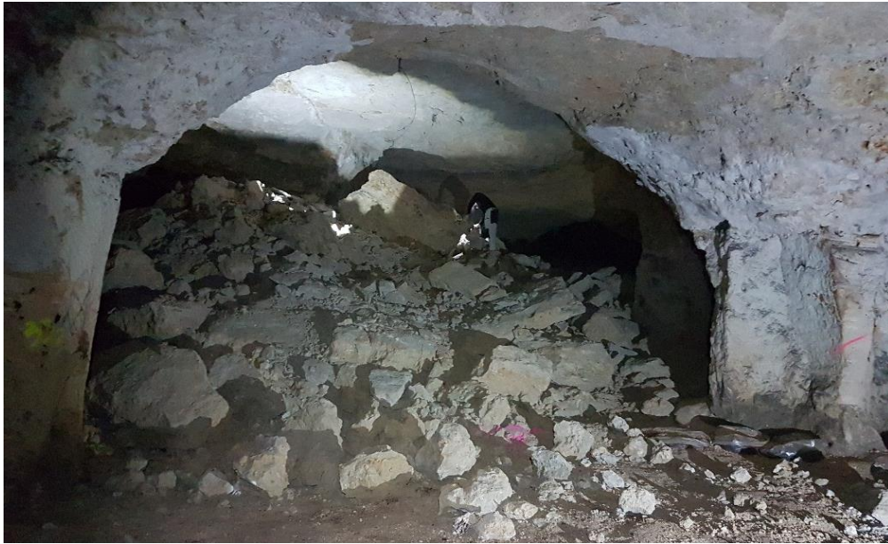
Illustration 25 : Exemple d'instabilité « évoluée » dans la carrière des Petites Hayes (Coulonges-sur-Sarthe – Orne)
