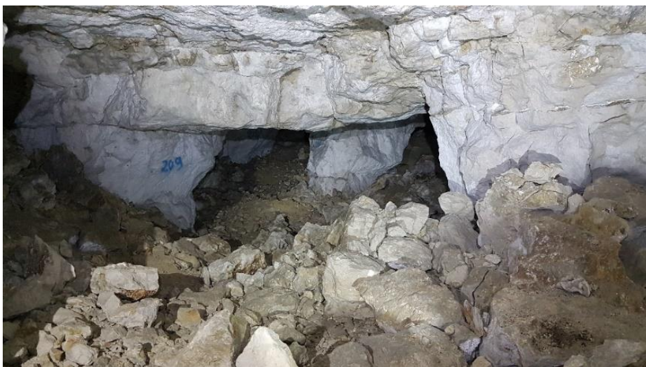
Illustration 28 : Exemple d'une limite supposée (ici dans la carrière Pontillon à Rémalard-en-Perche), qui correspond à une zone remblayée inaccessible. L'état des galeries et leur extension au-delà de cette limite ne sont pas connus
