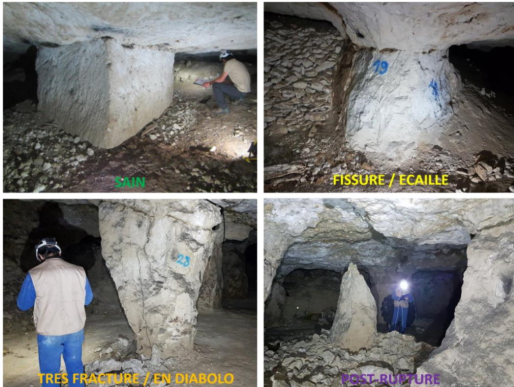
Illustration 23 : Illustration des 4 classes de stabilité des piliers
