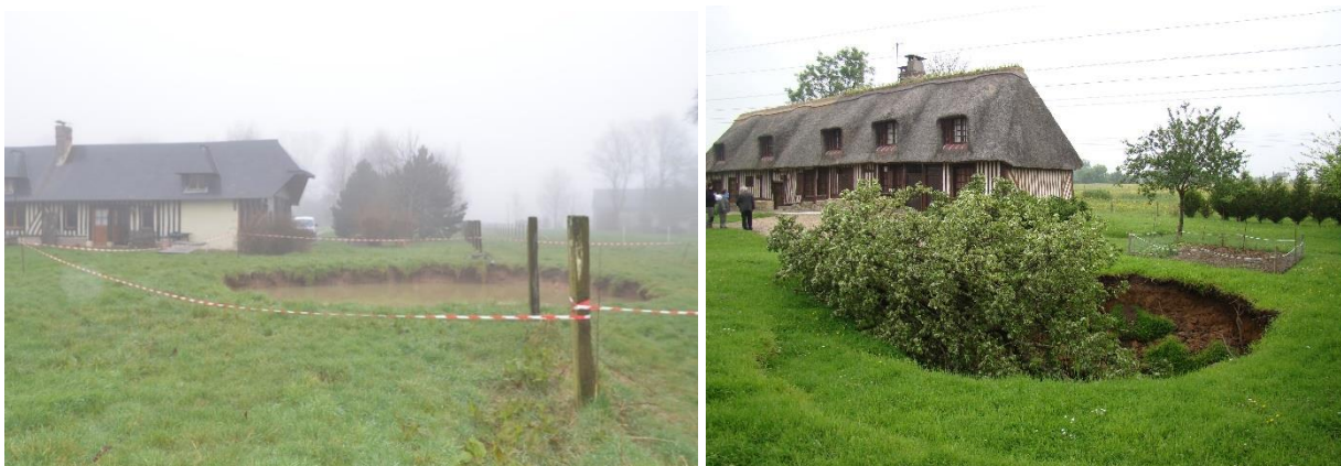
Illustration 10 : Exemples d'effondrements survenus dans le Pays d'Auge suite à la ruine de carrières souterraines anthropiques (à gauche, Bonnebosq (2018) et à droite, Formentin (2016))
