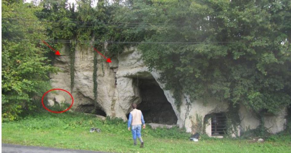
Illustration 12 : Exemple d'écailles et de blocs instables (flèches rouges) au niveau de l'entrée de la carrière de Beaufour-Druval (14). Certains étant déjà tombés (cercle rouge)
