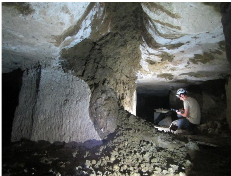
Illustration 26 : Exemple d'un conduit karstique vertical en cours de déboufrage dans la carrière des Curiers à Courgeon (Orne)
