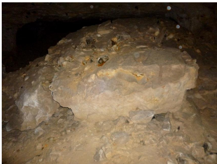
Illustration 16 – Chute du premier banc de toit dans la cavité est
