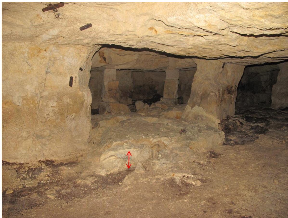
Illustration 21 – Chute du premier banc de toit d'épaisseur environ 50 cm (« pilier à bras » au font)
