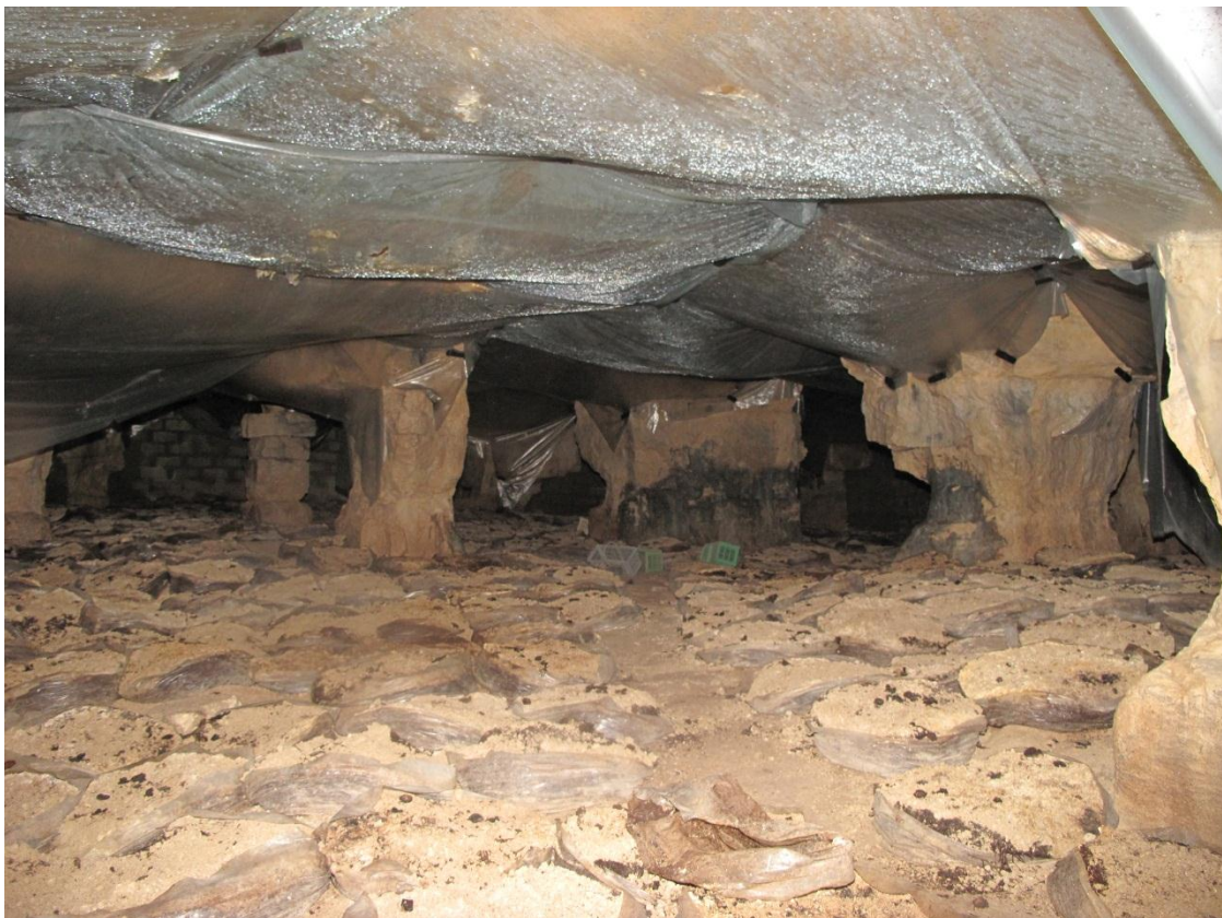
Illustration 13 – Vue d'ensemble d'une partie de la carrière avec trace de l'exploitation en champignonnière (sacs de culture, cagettes et bâche au niveau du toit)
