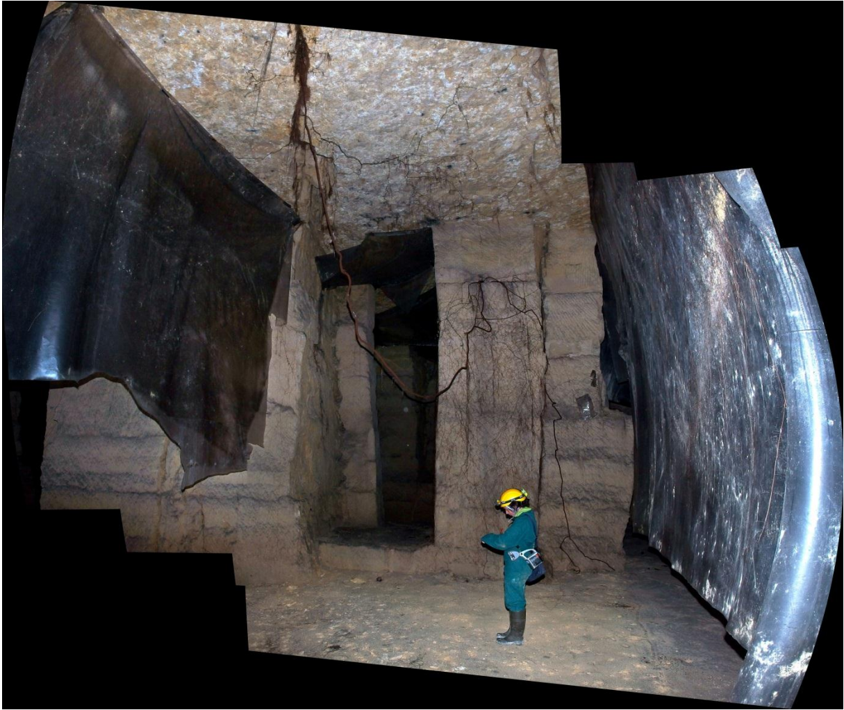
Illustration 57 – Fractures avec racines (zone K-j)
