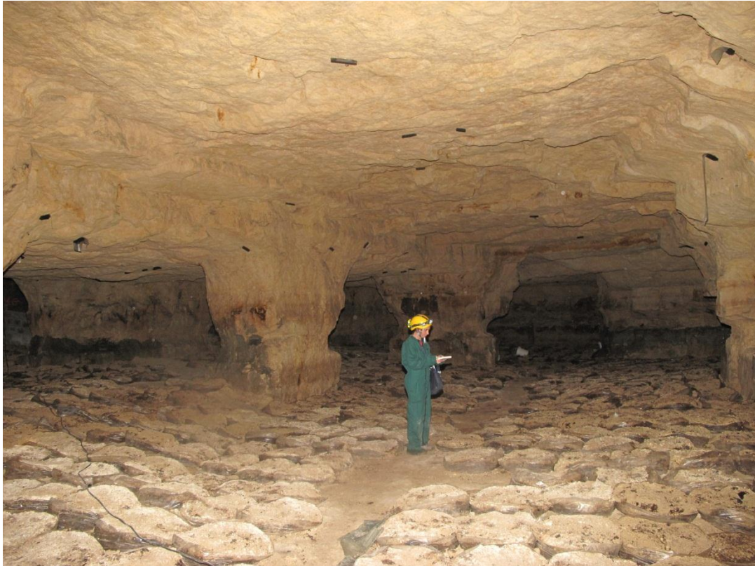
Illustration 16 – Exemple de chambre de grande dimension (9,5 m de large, 35 m de longueur, 4,3 m de hauteur)
