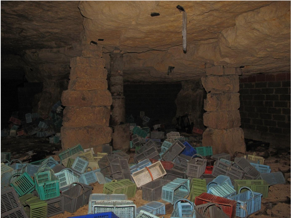
Illustration 25 – Premiers bancs de toit retenus par des piliers à bras
