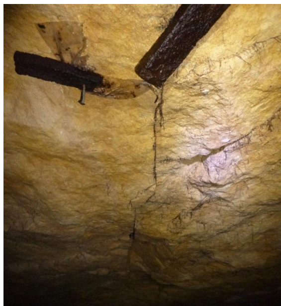
Illustration 20 – Présence de racines au niveau de fractures mécaniques
