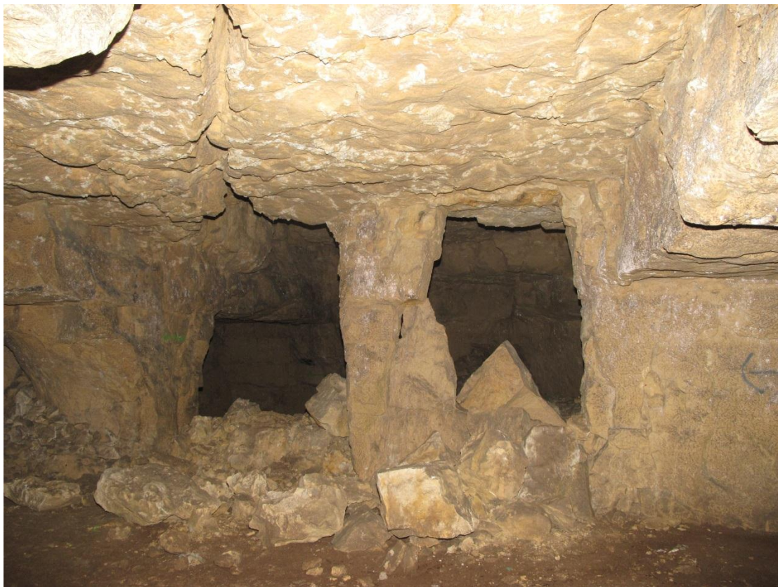
Illustration 50 – Défruitement d'un pilier (zone notée J)
