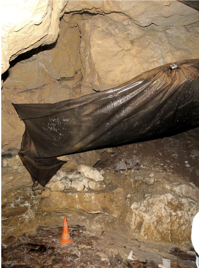
Illustration 35 – Zone en cours d'effondrement (zone notée J)
