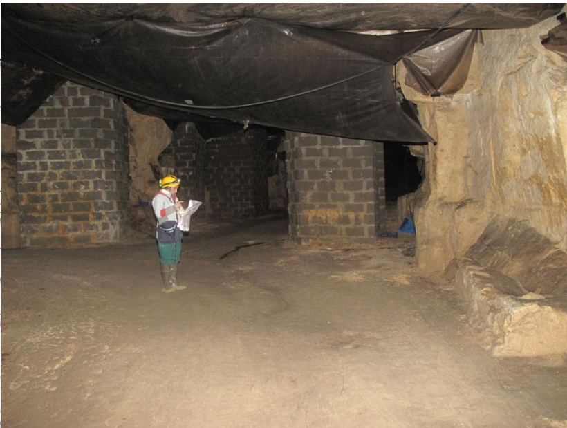
Illustration 39 – Zone confortée par des piliers maçonnés (zone I)
