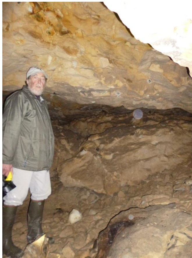
Illustration 22 – Chute de bancs de toit et remontée de voûte dans la troisième cavité (à l'ouest)
