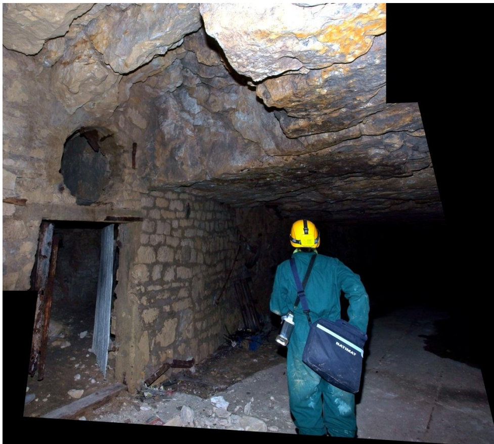
Illustration 53 – Toit dégradé avec chutes de blocs à 5 m de la sortie (zone K-d)
