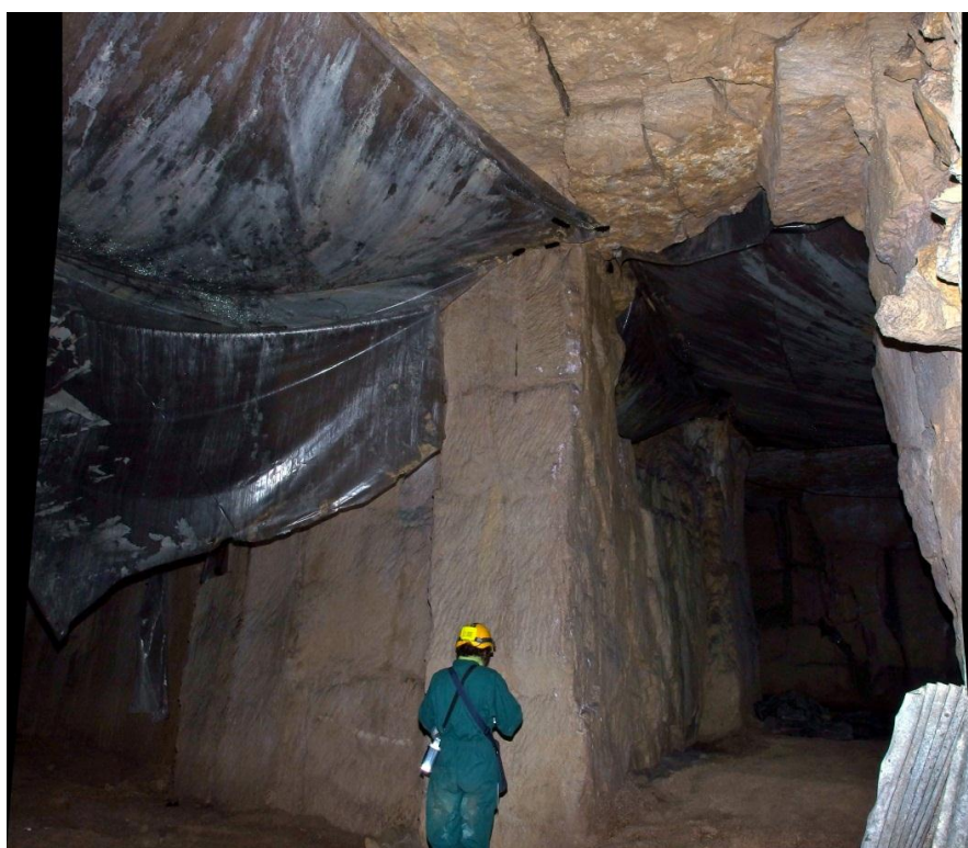
Illustration 56 – Fractures et présence de fines sur bâche plastique (ruissellement probable) (zone K-h)
