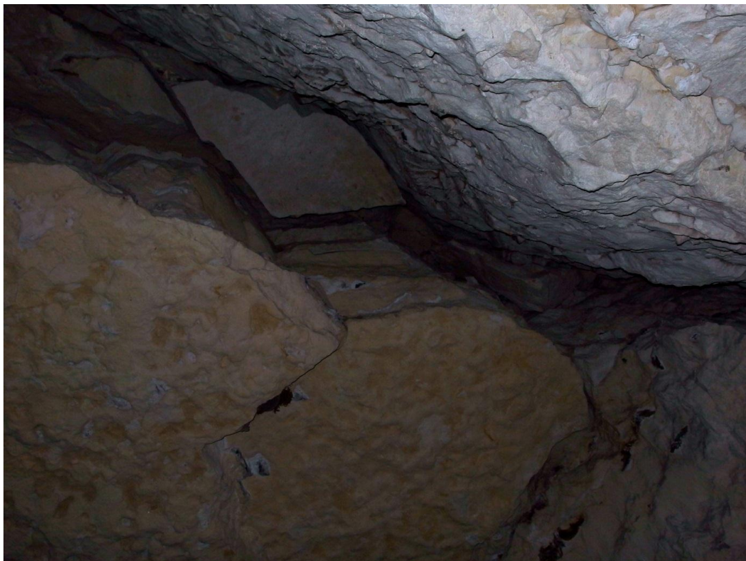
Illustration 24 – Fracture avec blocs désolidarisés dans la première salle au niveau du toit
