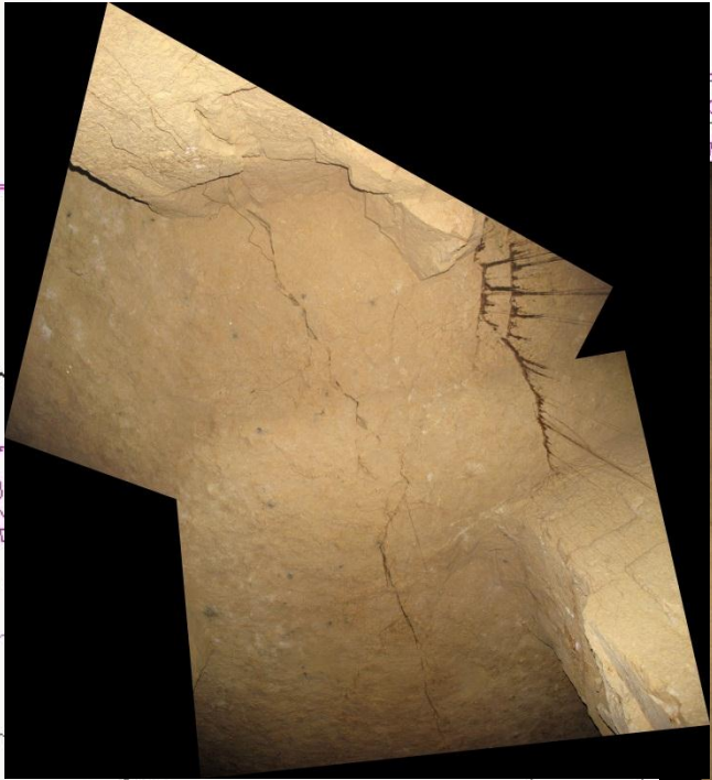
Illustration 41 – Vue du toit présentant des fissures mécaniques avec racines (zone I)
