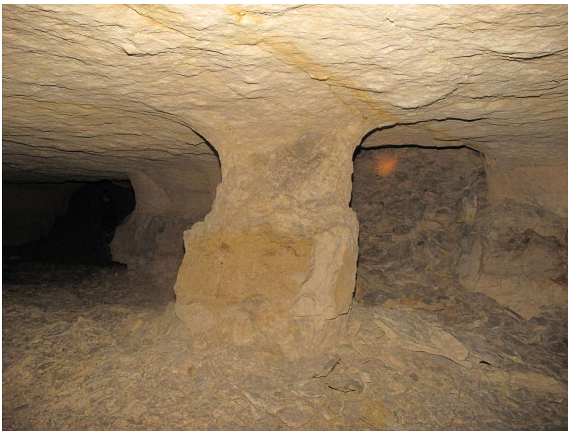
Illustration 30 - Ecaillage important du pilier conduisant à son défrètement en tête
