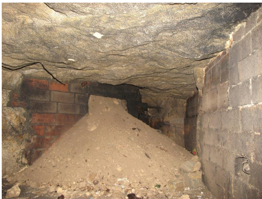
Illustration 33 – Puits rebouché depuis la surface
