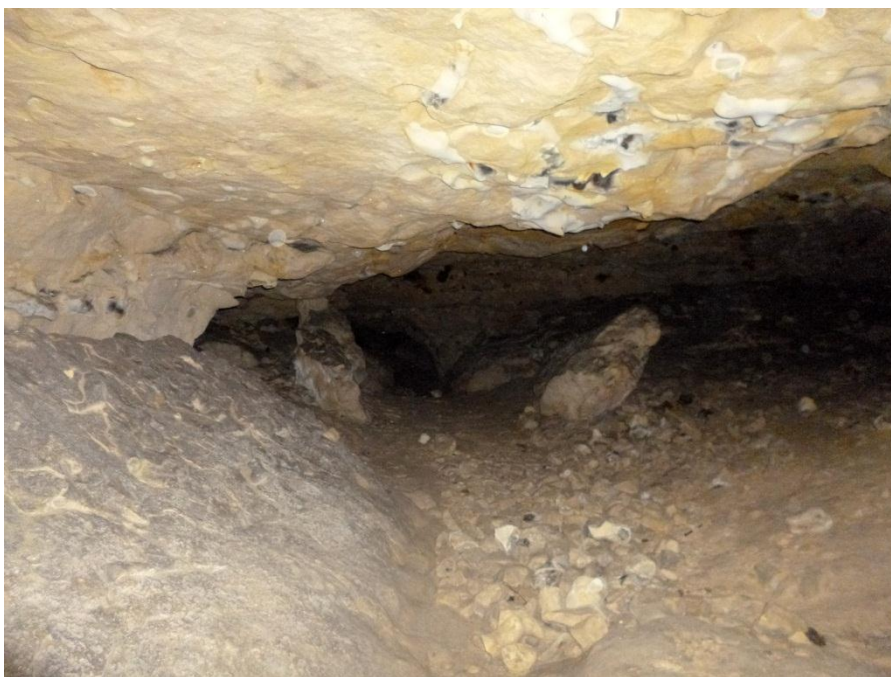
Illustration 19 – Chutes de blocs en provenance du premier banc de toit dans la cavité centrale
