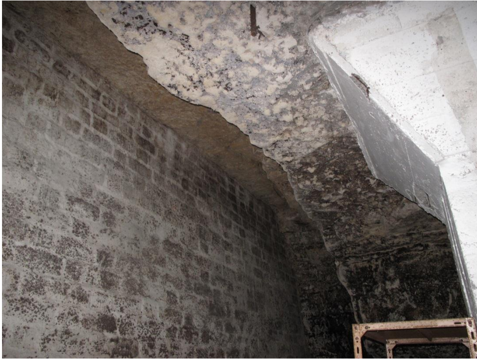
Illustration 15 – Fracture de décompression en fond de cavité
