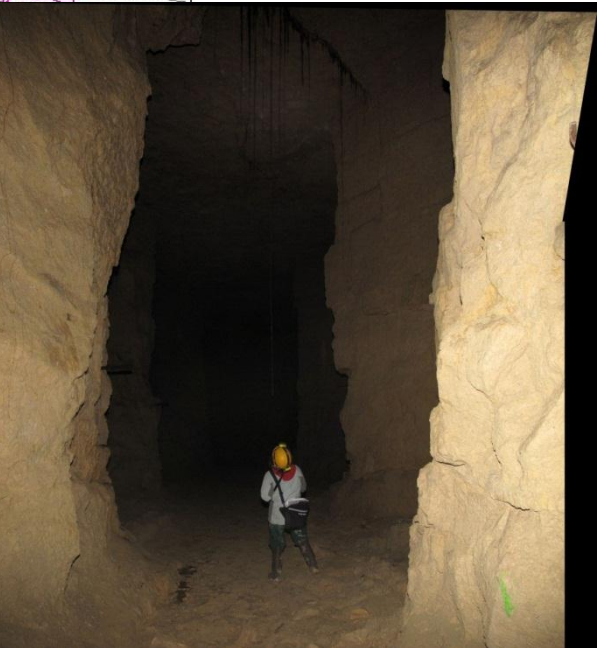
Illustration 42 – Présence de racines dans des fentes de tension (zone I, hauteur 8 m)
