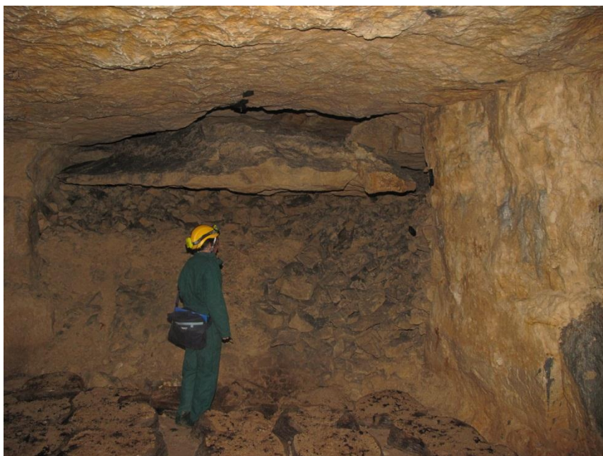
Illustration 22 – Premier banc de toit reposant sur les remblais
