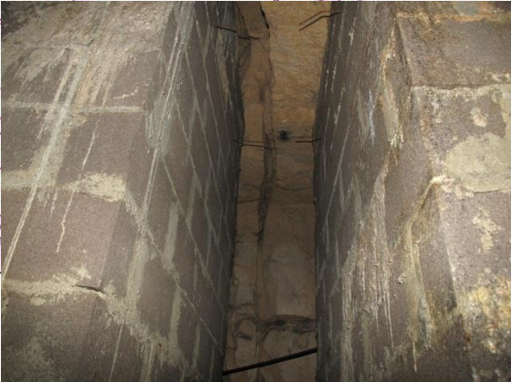
Illustration 40 – Piliers maçonnés de part et d'autre d'une diaclase (zone I)
