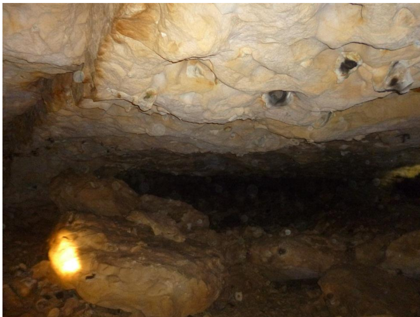
Illustration 23 – Chute de bancs de toit et fracturation du toit dans la troisième cavité (à l'ouest)
