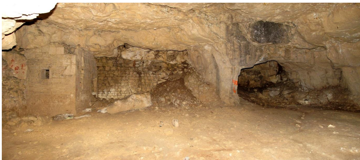
Illustration 48 – Chutes de toit au niveau des entrées (zone notée J)
