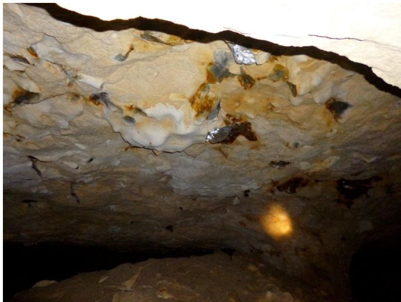
Illustration 14 – Présence de rognons de silex au toit de la cavité
