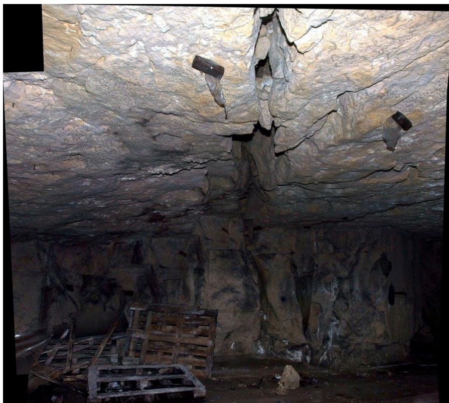
Illustration 54 – Fente de décompression et fissures mécaniques à 20 m de la sortie (zone K-d)
