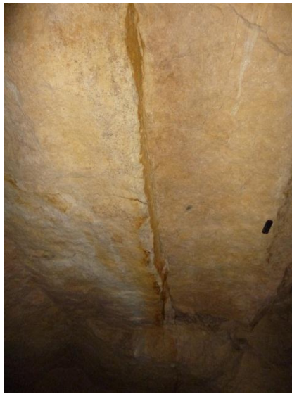
Illustration 18 – Fracture tectonique au niveau du toit de la carrière
