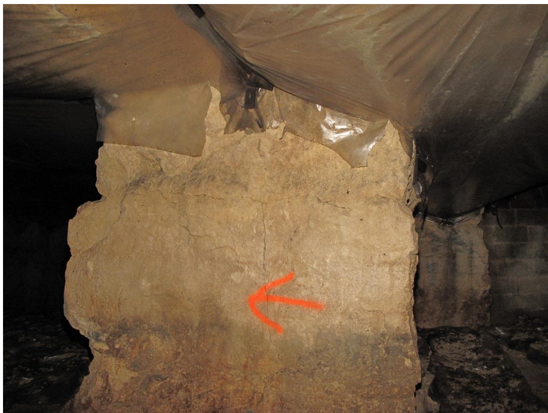
Illustration 26 - Fissuration mécanique du pilier
