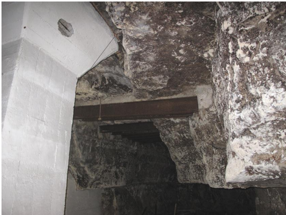
illustration 18 – Confortement d'un banc de toit par des fers H et des boulons
