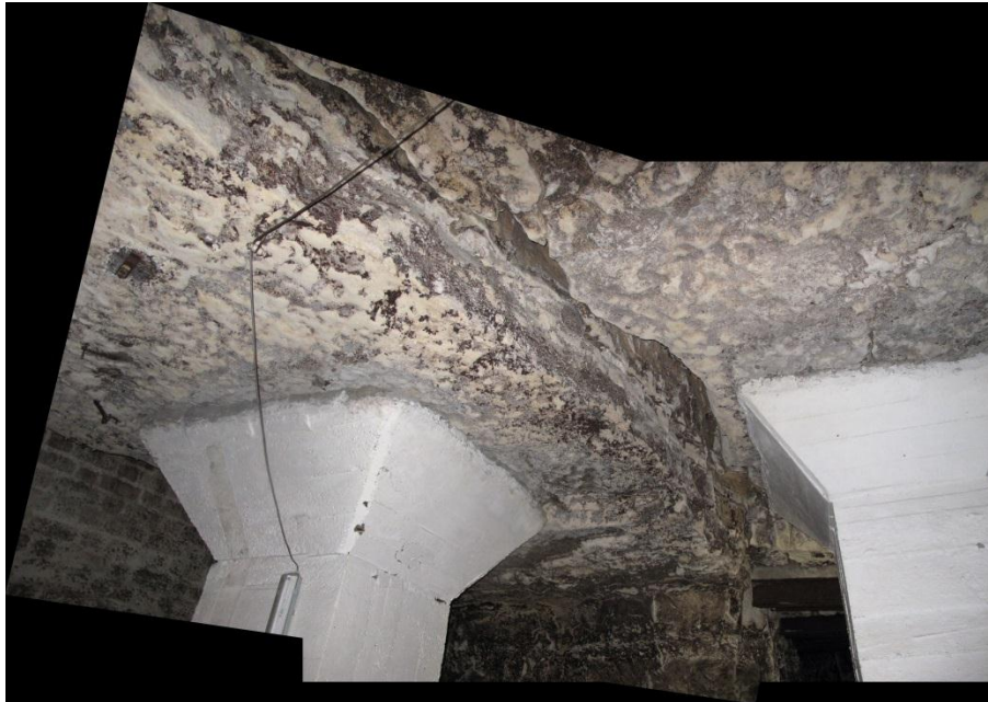
Illustration 14 – Fracture de décompression entre les deux piliers
