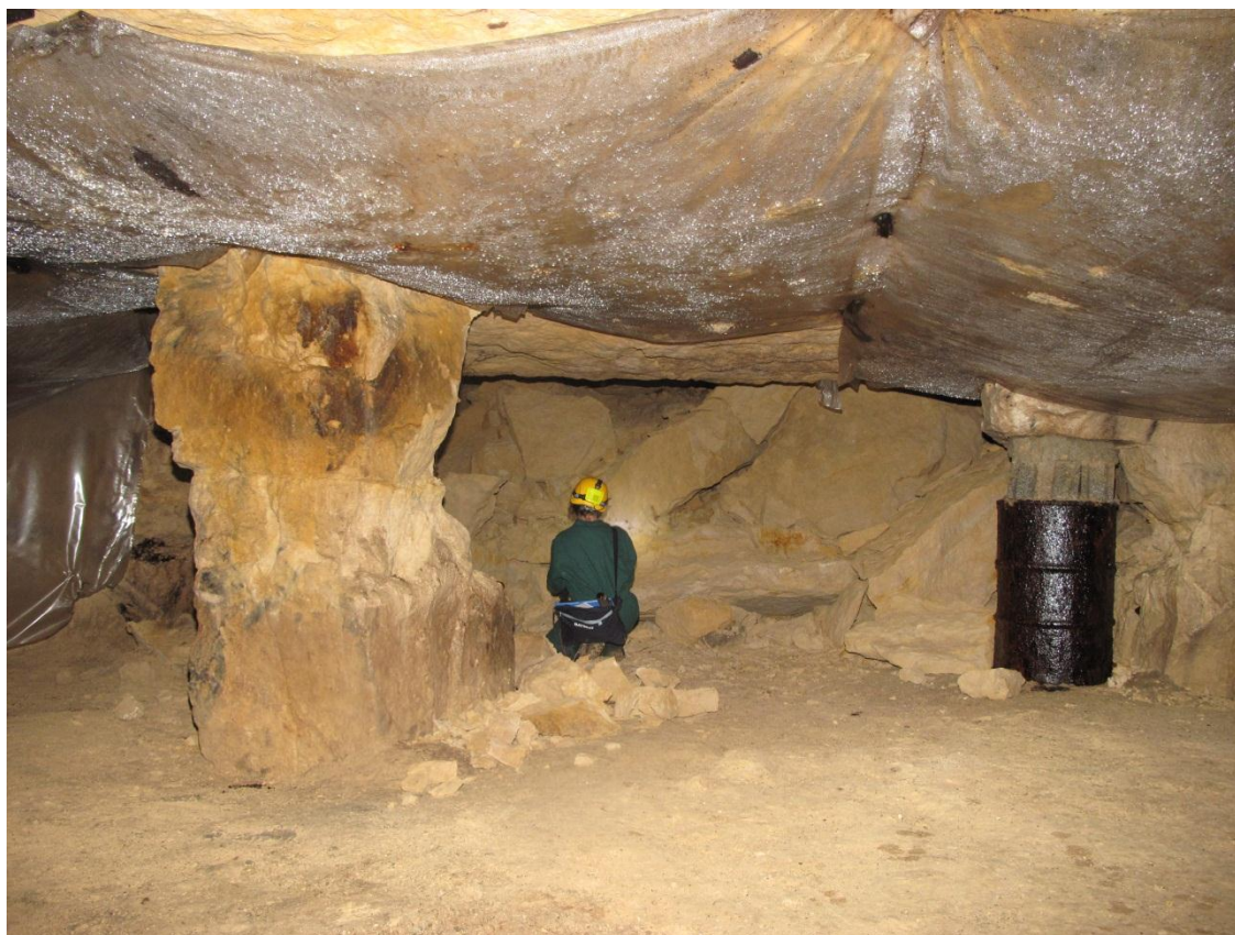
Illustration 29 – Chutes de blocs au niveau du pilier et réduction de section
