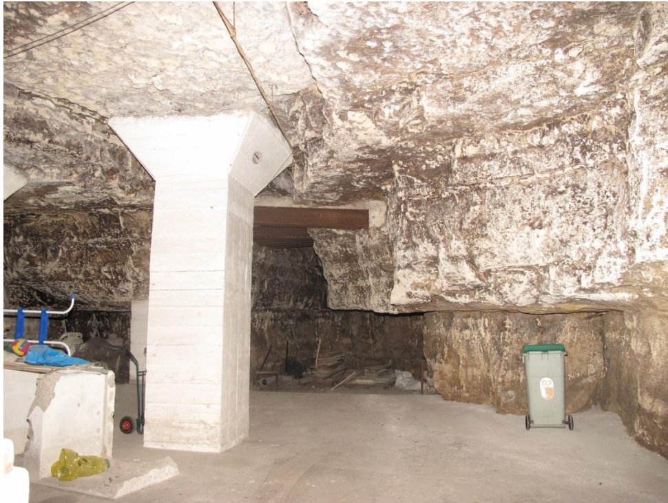
Illustration 17 – Léger basculement du pilier
