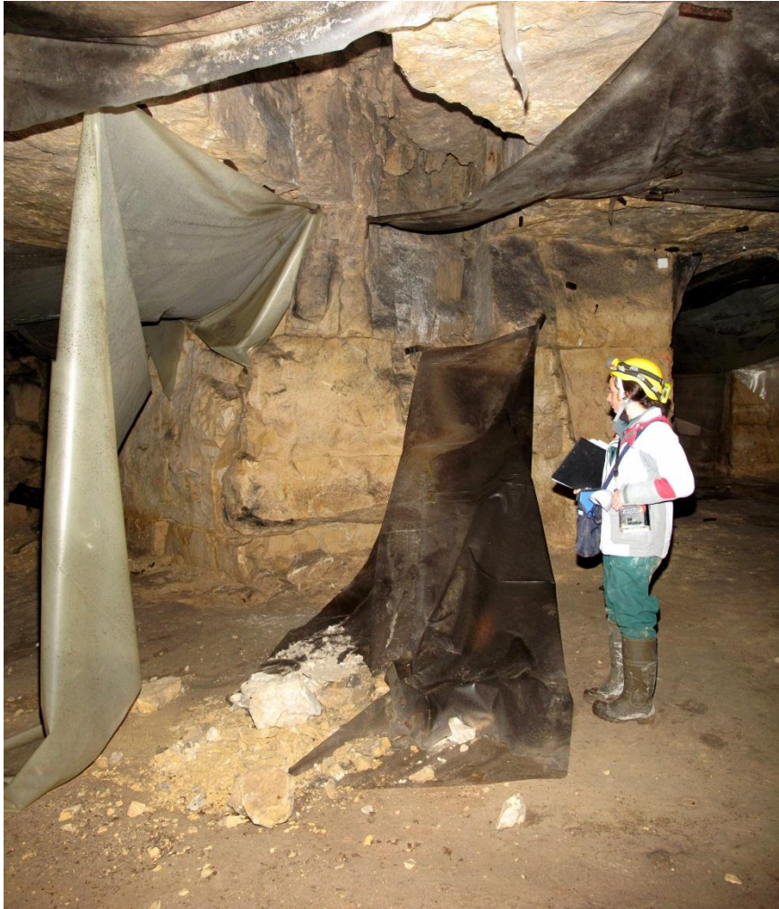
Illustration 37 – Chutes de blocs au niveau d'une diaclase (zone notée G)
