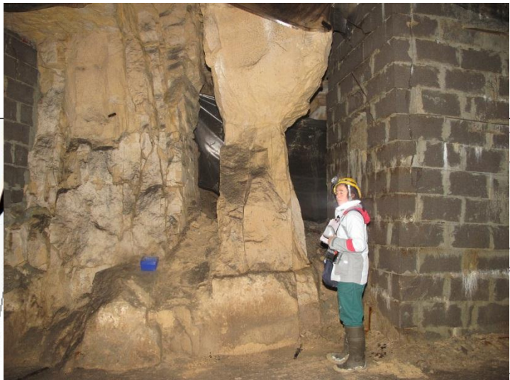
Illustration 43 – Piliers en diabolos et pilier maçonné fortement dégradé (zone I)
