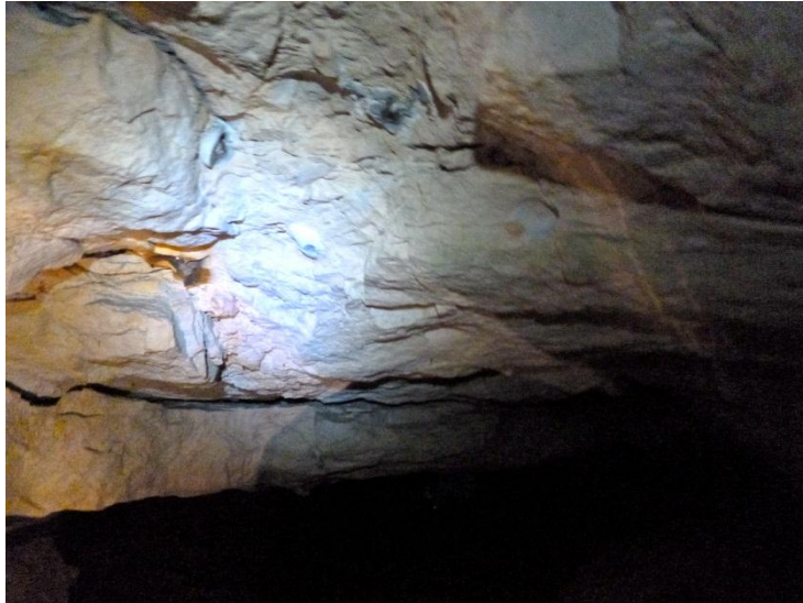
Illustration 17 – Plusieurs niveaux de décollement des premiers bancs de toit
