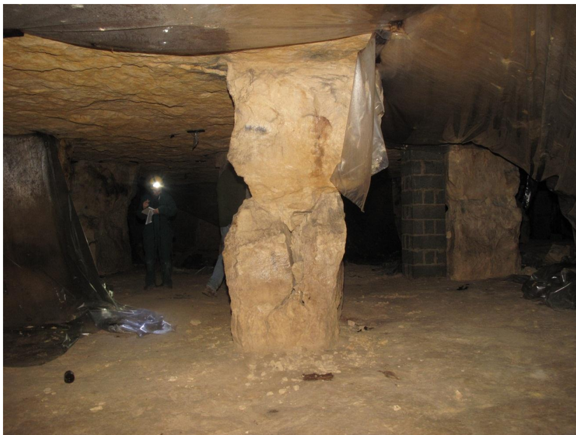
Illustration 28 – Ruine du pilier par compression (fracturation verticale)
