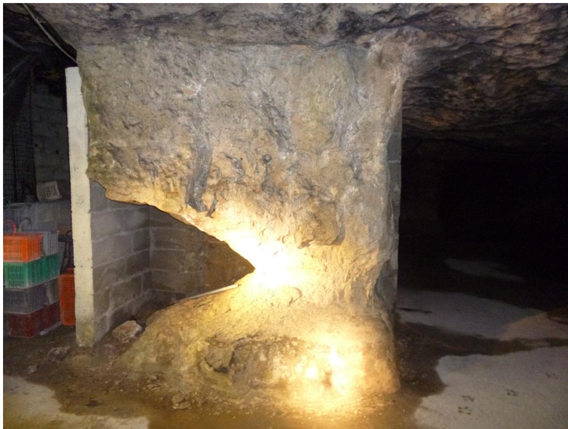
Illustration 32 – Pilier en diabolo au niveau de l'entrée de la carrière d'Aubigny
