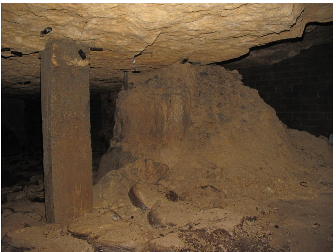
Illustration 31 - Ecaillage et défournement de blocs instables
