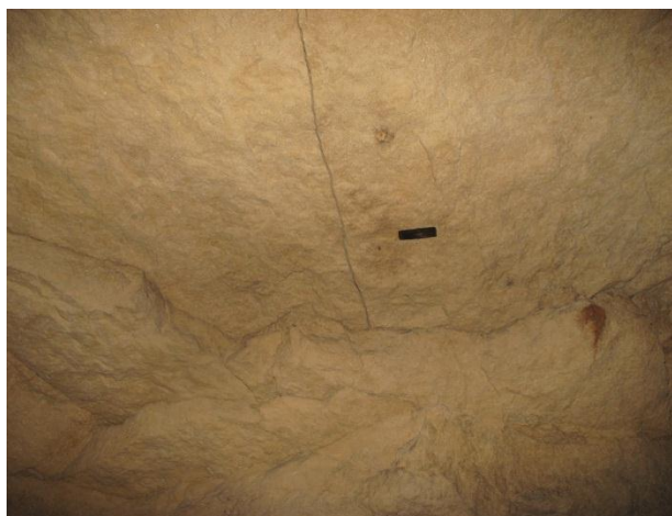
Illustration 19 – Fissuration mécanique du toit
