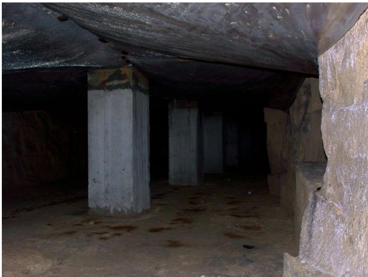
Illustration 55 - Zone confortée avec présence de piliers en béton (zone K-e)
