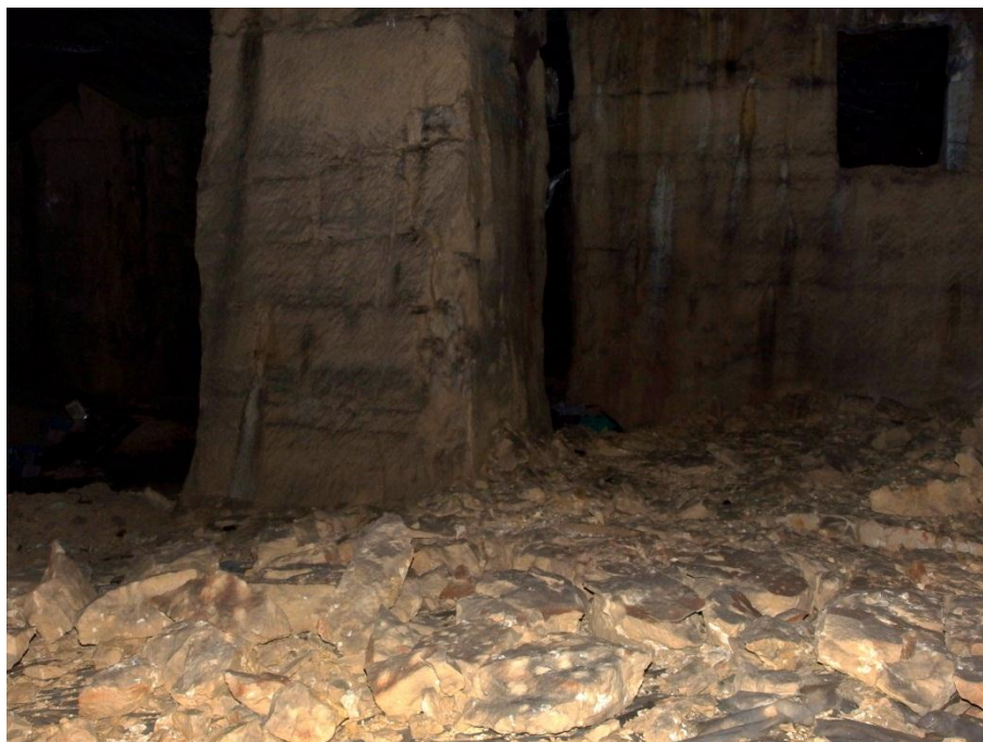
Illustration 27 - Chute du premier banc de toit dans la zone F de la carrière de Pochiet (secteur nord)
