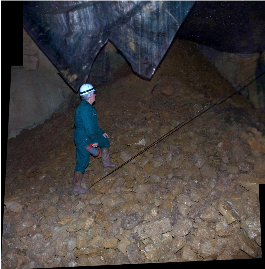
Illustration 22 – Cône de remblai déversé depuis la surface
