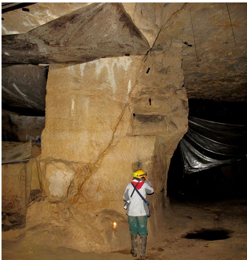
Illustration 34 – Discontinuité structurale traversant un pilier (zone notée H)
