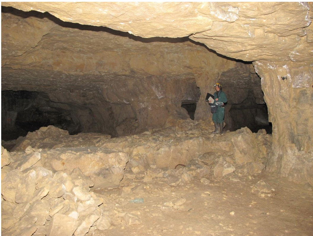
Illustration 49 – Chute du premier banc de toit et amorce de cloche de fontis (zone notée J)
