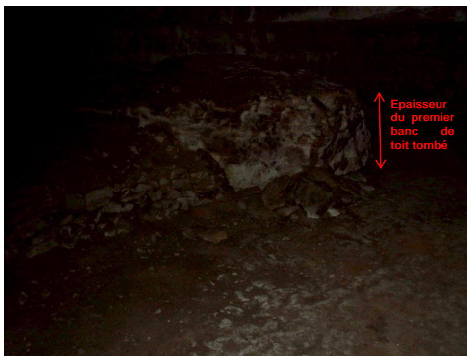
Illustration 25 – Chute du premier banc de toit dans la deuxième salle (en entrant à droite)
