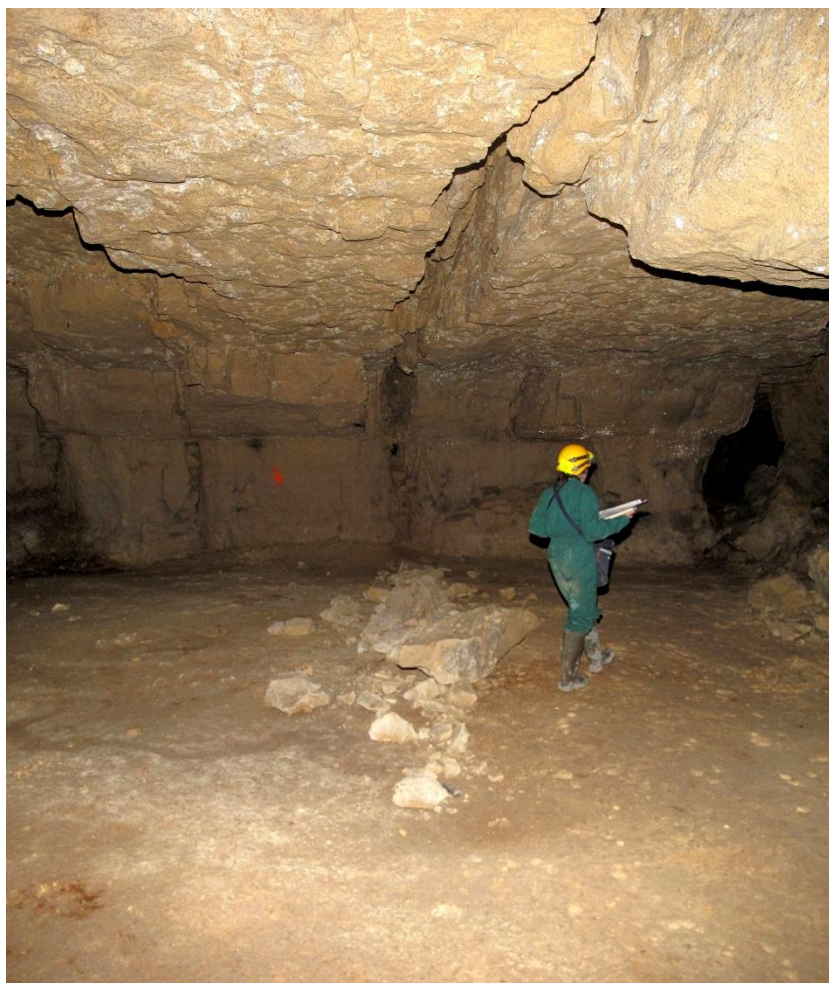
Illustration 33 – Chute de blocs au niveau d'une fracture de décompression (zone notée J)
