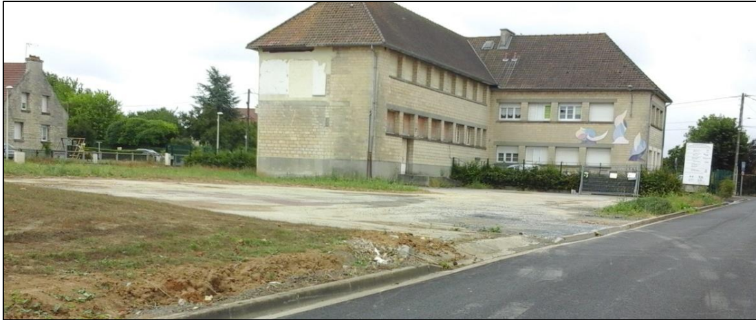
Illustration 42 : Vue du bâtiment rue de la mine après travaux.
