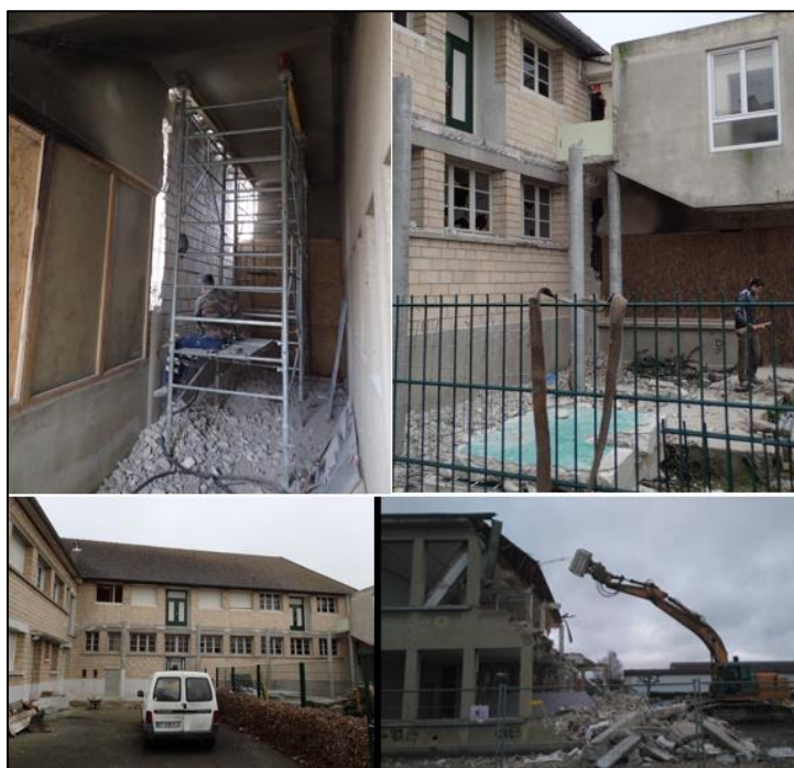
Illustration 34 : Désolidarisation du bâtiment et déconstruction.
