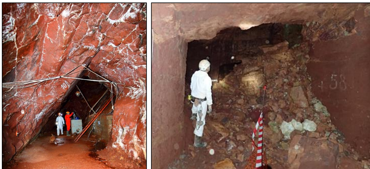
Illustration 43 : Inspection visuelle par le fond.
