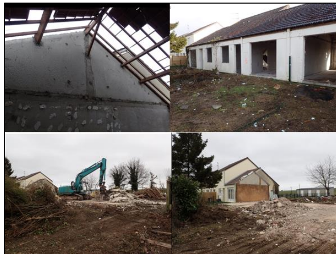
Illustration 25 : Déconstruction et nettoyage.
