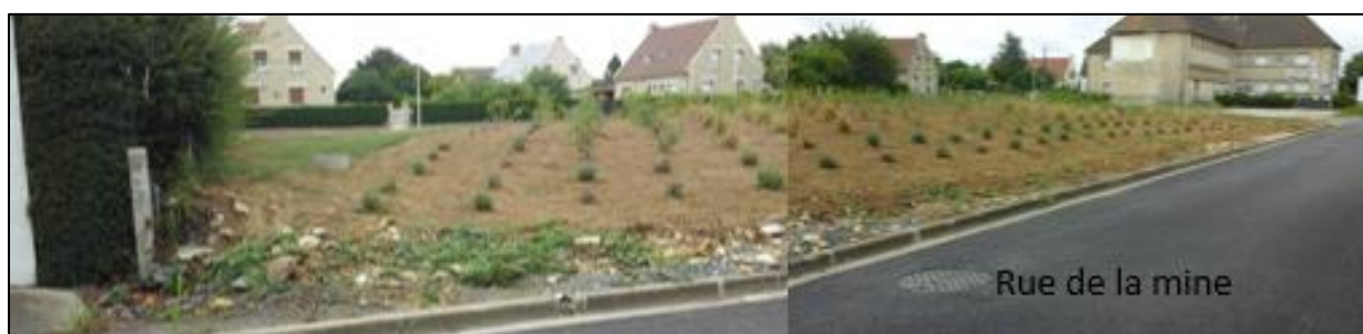
Illustration 41 : Vue du terrain rue de la mine après travaux.
