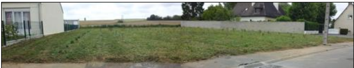
Illustration 30 : Vue du site des 4 maisons après travaux au 2 rue des Jardins.
