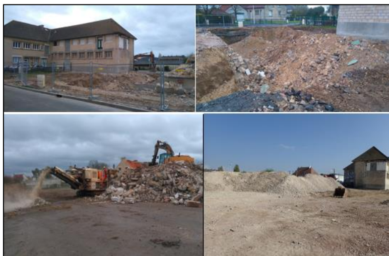
Illustration 35 : Fin de la déconstruction et du concassage
