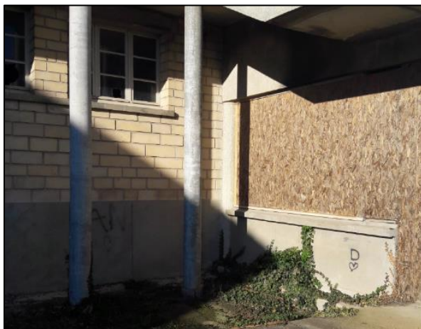
Illustration 32 : Désolidarisation du collège concernant la partie à démolir.
