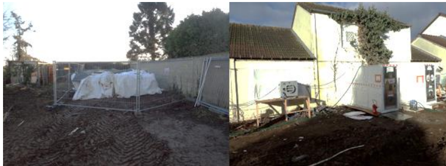
Illustration 24 : Zone de stockage de produit amianté, filtre et issue de secours.
