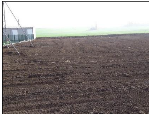
Illustration 28 : Nettoyage de la terre végétale après la pose de la géogrille.
