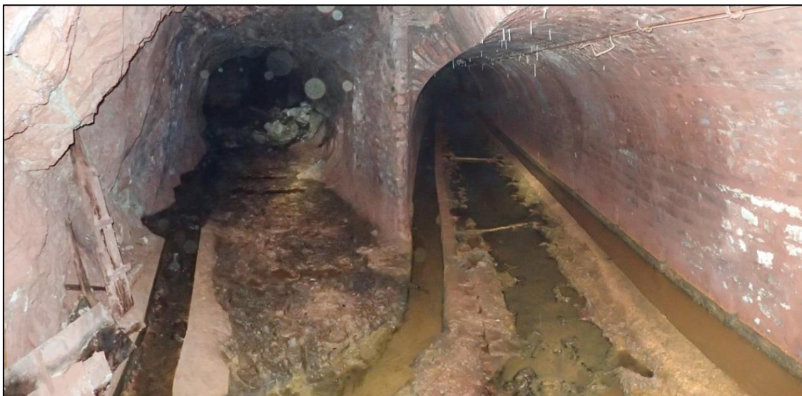
Illustration 57 : TB de l'Orne, inspection visuelle de la galerie et de l'écoulement d'eau.
