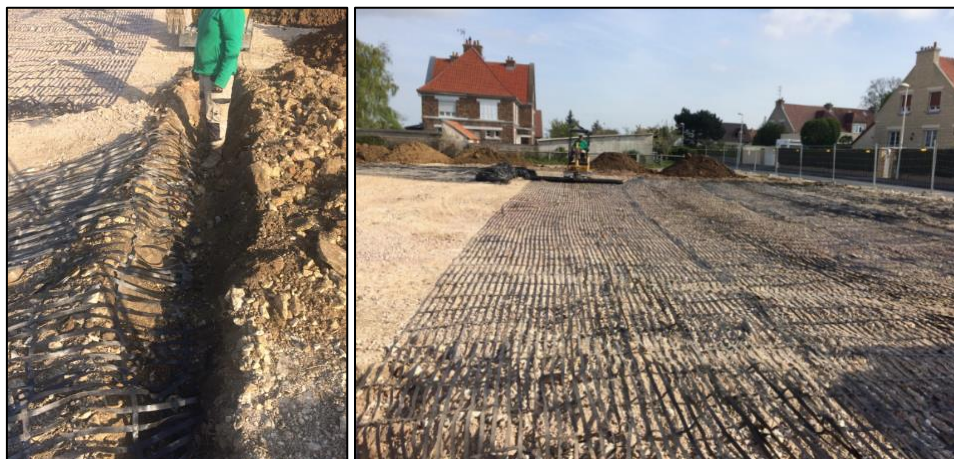
Illustration 36 : Mise en œuvre de la géogrille.
