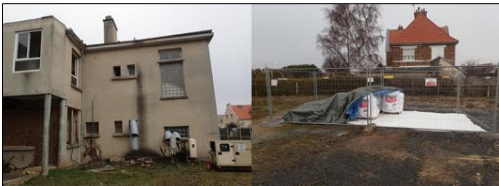
Illustration 33 : Mise en place de la filtration et zone de stockage de produit amianté.
