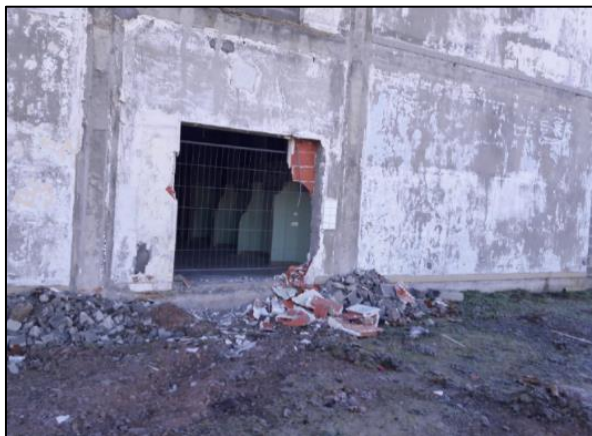
Illustration 31 : Création d'ouverture dans le collège pour le curage.
