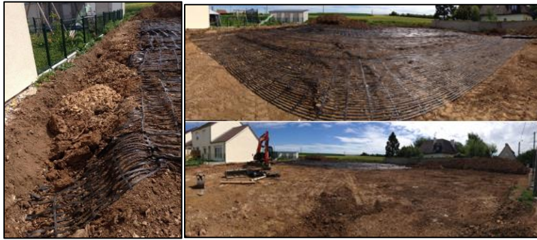
Illustration 27 : Mise en œuvre de la géogrille avec tranchée d'ancrage.
