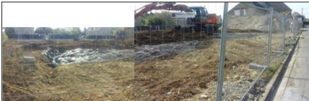
Illustration 37 : Mise en œuvre de la terre végétale après la pose de la géogrille.
