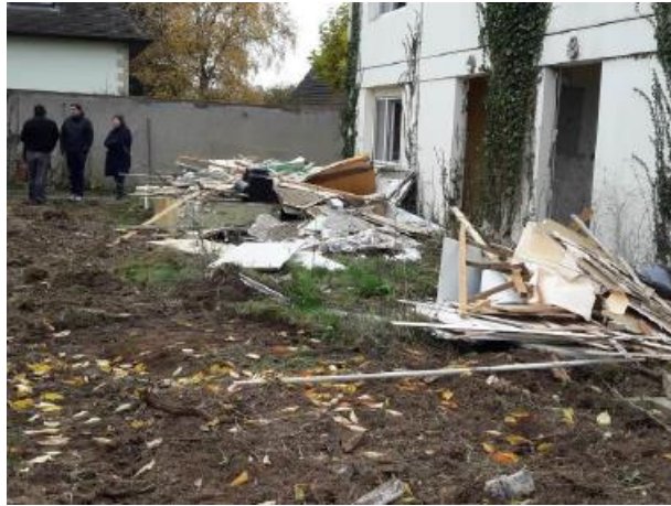
Illustration 22 : Curage des logements.
