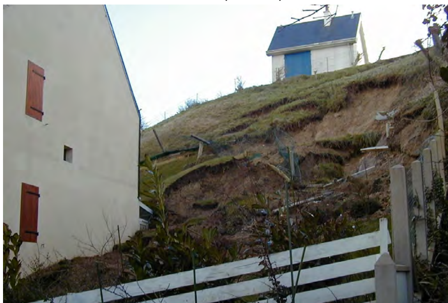
Glissement de terrain à Port-en-Bessin (Calvados)
