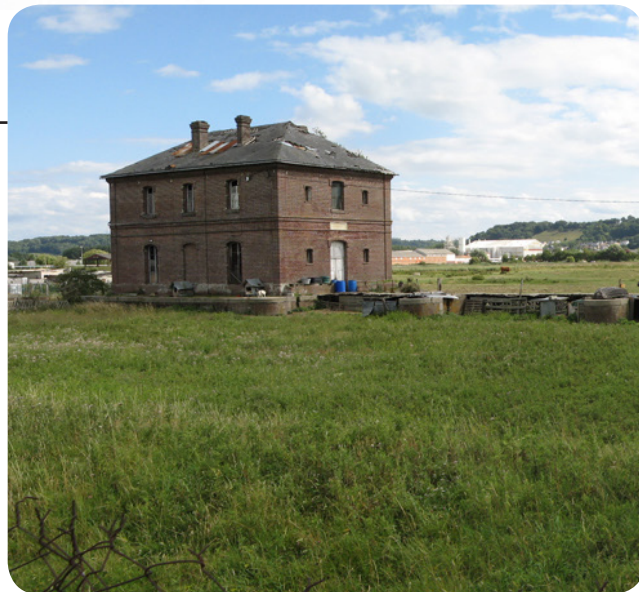
Les vestiges des vannes du bassin des chasses ainsi que le bâtiment se retrouve au coeur d'un territoire en pleine mutation
