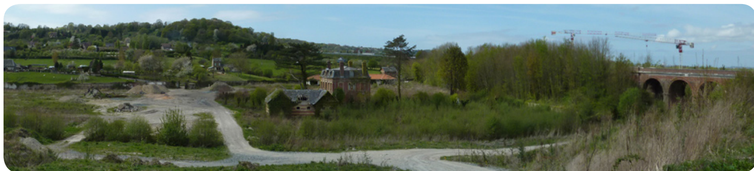
Partie du cours d'eau de l'Orange à aménager en espace vert de proximité
