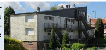
Gendarmerie de Blangy-sur-Bresle précédant les travaux de démolition
