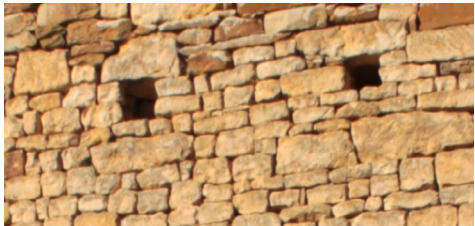
Mur en calcaire.
