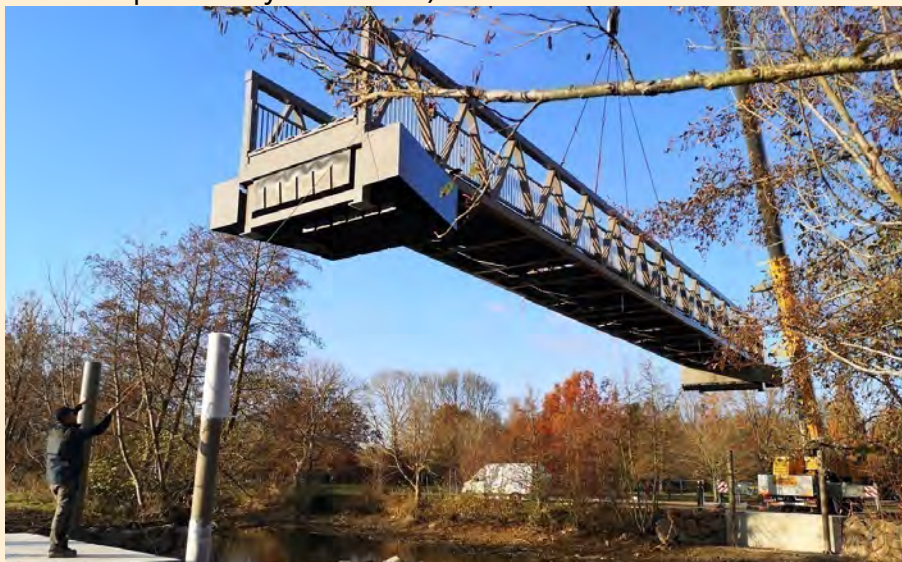
Pose d'une passerelle cyclable à Alençon
