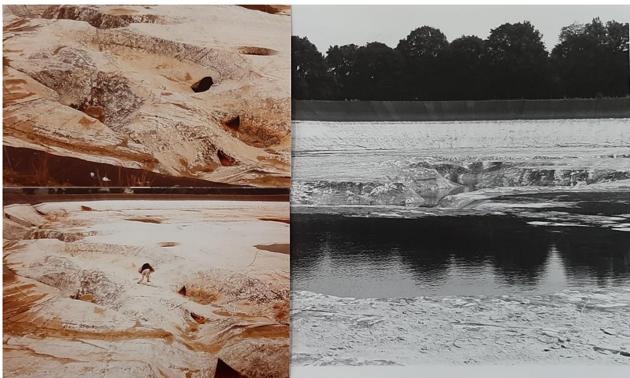
Illustration 65 : Effondrements multiples survenus dans les bassins de stockage de Norville au début des années 1980 (source : BRGM)
