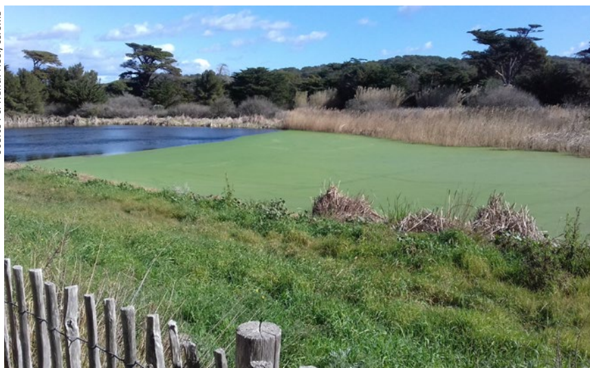
Illustration 12 - Lagune paysagée de 4000 m 2 , assurant la première phase du post-traitement des EUT de la station d'épuration de Porquerolles (Boue activée, 4500 EH). Valorisée le long d'un circuit touristique, cette eau traverse ensuite deux autres lagunes puis passe par un filtre à sable autonettoyant sous pression, avant d'être utilisée pour arroser le verger conservatoire de l'île.
