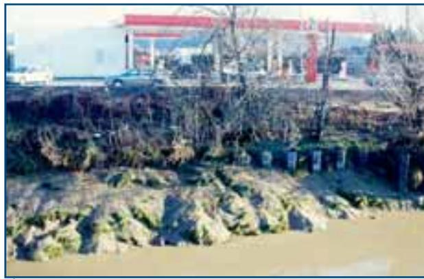
Figure 50 : Exemple de formation de « ravines » en berge dues à un profil trop raide en présence de contraintes de marées (ici la Garonne en ville de Bordeaux avec des ouvrages de renforcements de berge en palplanches). ≈
