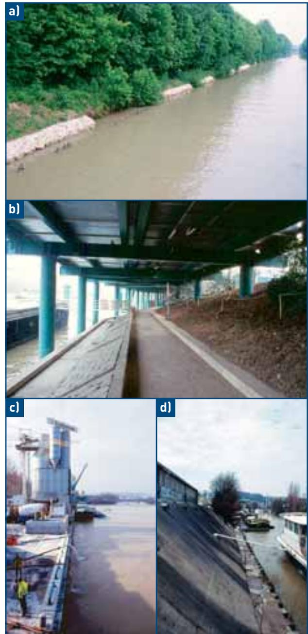
Figure 42 : Quelques exemples d'aménagements et d'usages particuliers des voies navigables : a) Canal de dérivation de la Marne et berges artificielles. b) Infrastructures routières et berges minéralisées en bordure de Seine naviguée. c) Quai de chargement en bordure de Seine. d) Bateaux « logement » et berge artificielle en bordure de Seine. 🌊
