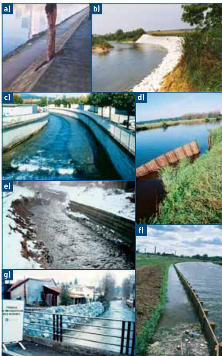
↑ **Figure 29** : a) Perrés en milieu urbain. b) Enrochement de berge en secteur agricole. c) Murs en traversée urbaine. d) Palplanches en protection de berge de rivière naviguée. e) Palissade en rondins de bois. f) Technique des «*tunages-bois*» en protection de berges de voies navigables. g) Sans commentaire !
