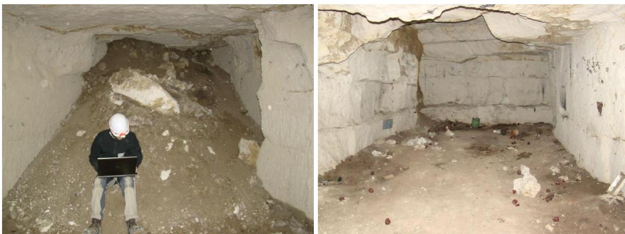
Illustration 16 : A gauche, extension supposée masquée par un cône d'éboulis (représenté sur les plans par un pointillé) et à droite un contour avéré (front de taille)
