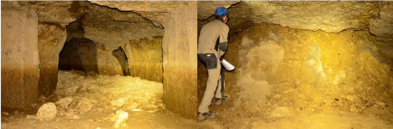
*Illustration 19 : Illustration des deux types d'instabilités de toit : à gauche, les chutes de toit et à droite, un éboulis lié à la remontée d'une cloche de fontis – carrière de Loissail « Le Bas Champailaume »*
