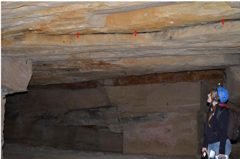
*Illustration 20 : Illustration d'une zone de décollement de 1<sup>er</sup> banc de toit dans la carrière de Béný-sur-Mer « Le Rocreux »*
