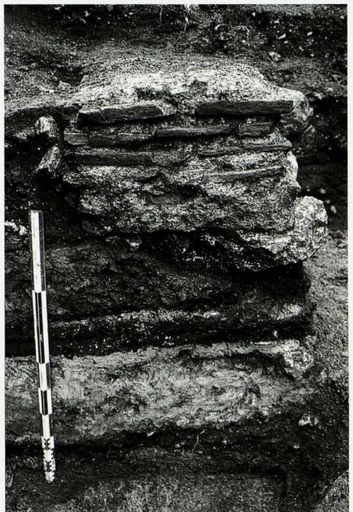
Fig. 15 - LISIEUX, pavillon Nicolas Vauquelin. Base de colonne (brique) de la galerie orientale.
