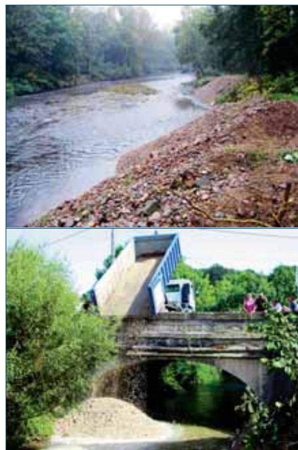
↑ Figure 21 : En haut, exemple de dépôt de matériaux le long de la berge en attente d'une reprise par le cours d'eau l'Azergues (69). En bas, déversement de matériaux dans la Scie (76). ≈
