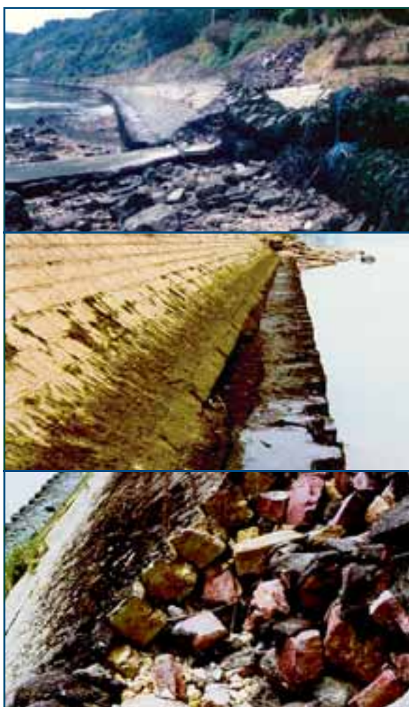
↑ Figure 69 : Exemple de protections de berges de Seine avec palplanches et perrés puis détail de détérioration des perrés. ≡
