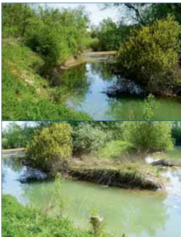
↑ Figure 36 : Vues des travaux effectués. ≈
