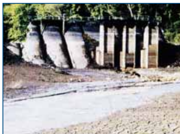
Figure 42 : Vue de l'ancienne retenue après sa vidange et du barrage de Kernansquillec en cours de démolition (source : brochure du Ministère de l'Ecologie, du Développement et de l'Aménagement durables). 🌊
