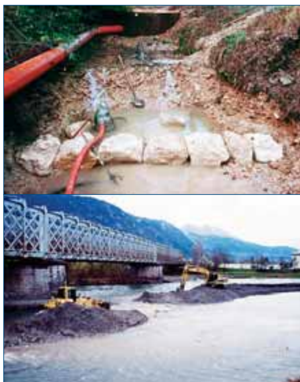
Figure 25 : Exemple de dérivation des eaux sur un petit cours d'eau en haut et batardeaux en graviers sur un plus grand cours d'eau en bas. ≈
