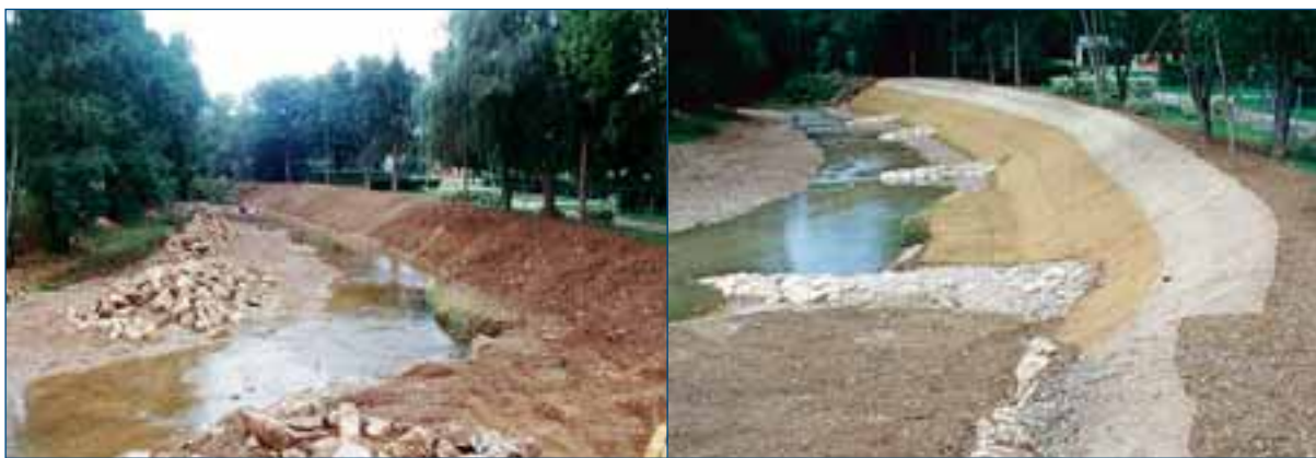
↑ Figure 11 : Travaux de démontage des empièvements existants (30.08.01) puis de réutilisation des blocs dans le cadre de la mise en place d'épis déflecteurs (18.09.01). ≈
