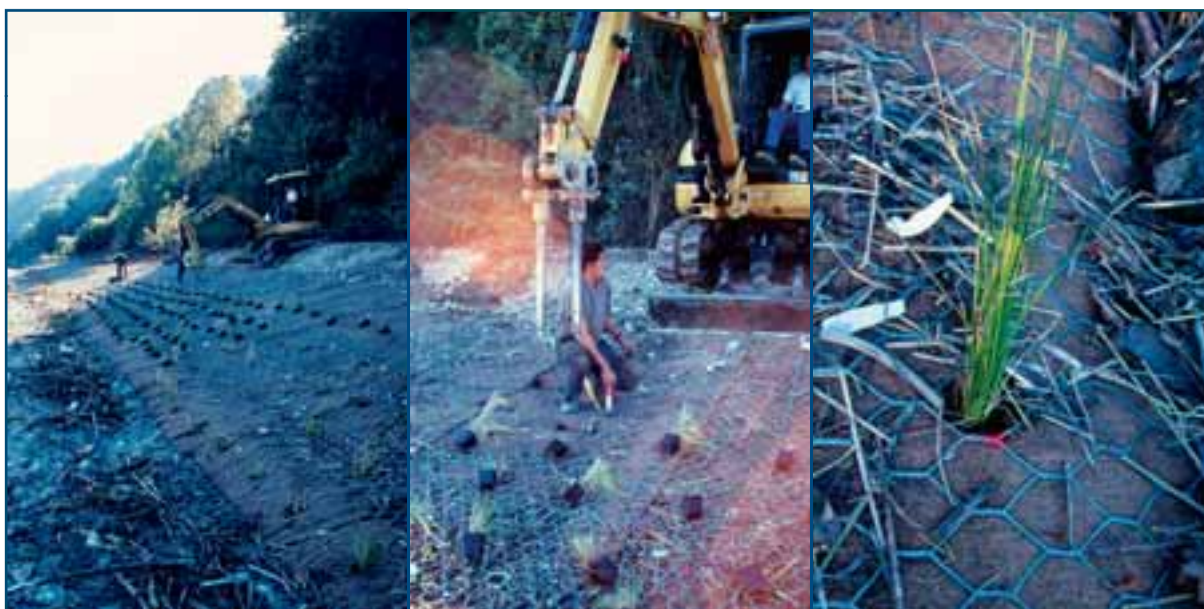
Figure 75 : (27.10.05) Les hélophytes sont « prédisposés » sur la berge et plantés entre les mailles du treillage métallique avec une légère découpe préalable des géotextiles biodégradables. Le treillage métallique en couverture est ensuite agrafé avec des « doubles agrafes » métalliques. ≈
