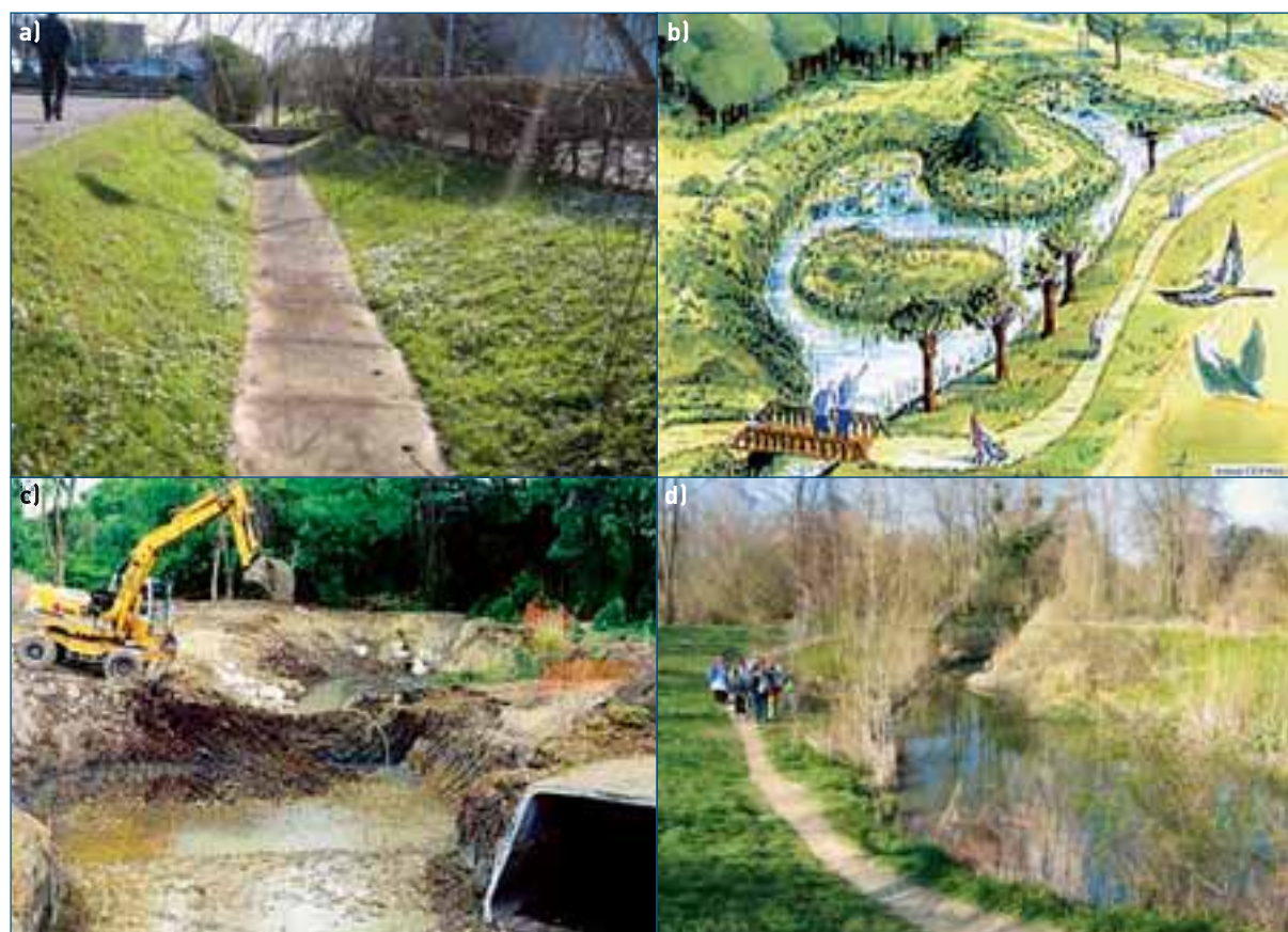
↑ Figure 57 : Vues du secteur restauré. a) Amont du secteur restauré. b) Esquisse du projet. c) Travaux de réouverture (2003) (noter la présence d'une partie du collecteur à droite) [source b) et c) : atelier Cepage]. d) Secteur restauré (2007) [source a) et d) : Malavoi].
