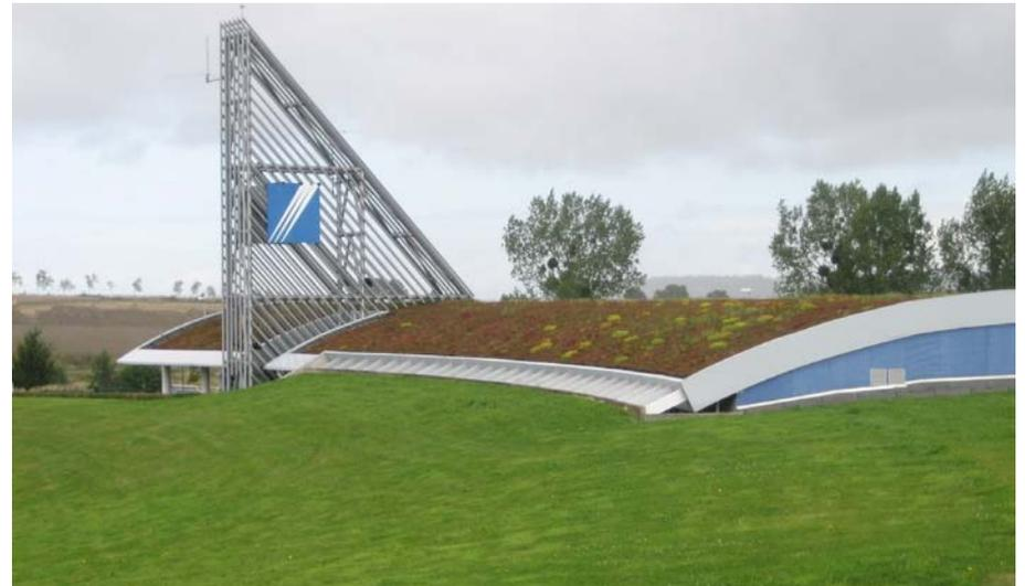
La noue empierrée en bordure de voie et la toiture végétalisée (DDE de la Manche) permettent de réguler les rejets d'eaux pluviales vers le milieu naturel.
