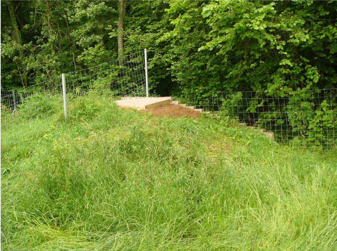
Dispositif de sortie d'emprise pour sanglier et chevreuil : une butte de terre de 1,20 m de hauteur réalisée dans les angles des emprises. L'animal descend vers l'extérieur, mais ne remonte pas.
