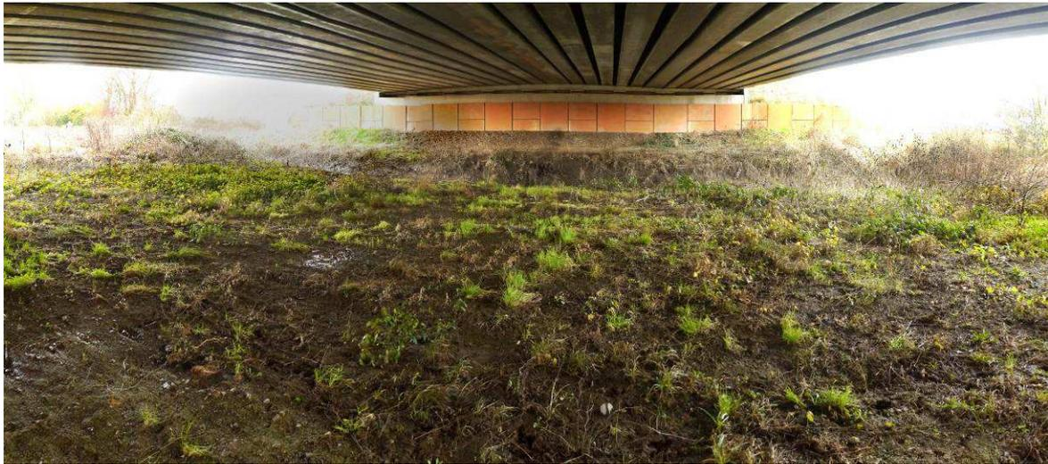
1<sup>ère</sup> travée/6 à l'extrémité ouest – 30 m de largeur, le 10/01/2013. La végétation s'est développée sous l'ouvrage, notamment grâce à l'abondance de l'eau (inondation hivernale et humidité de la vallée).
