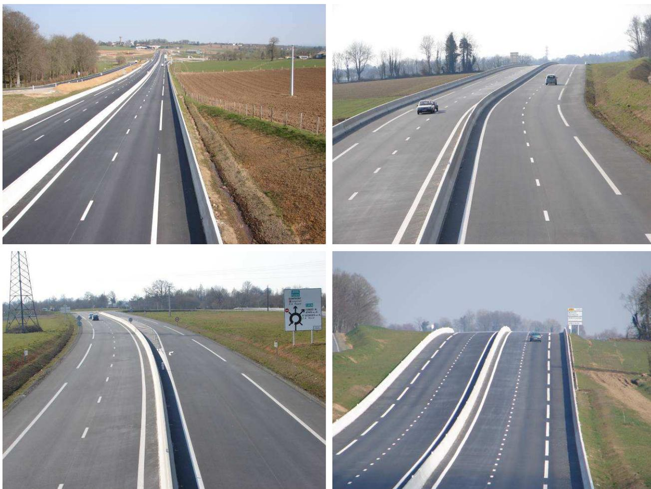
RD924 Première section aménagée de 4 km. Différentes dispositions des glissières béton armé sont mises en place : de manière systématique sur le terre-plein central et, en fonction des courbes, le long des bandes d'arrêt d'urgence. Le 2 avril 2013 © FDC61.
