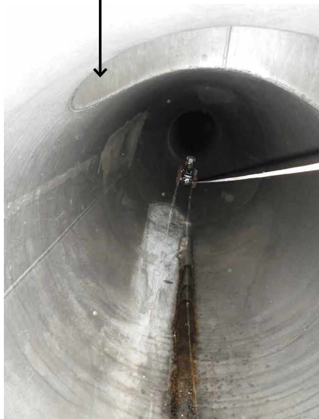
Passage d'une caméra dans un collecteur d'assainissement.
