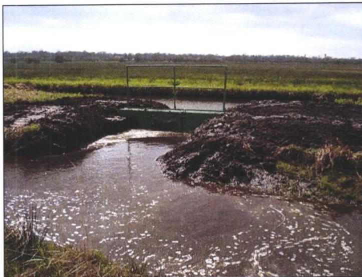
Figure 2 : Photographie de l'ouvrage à batardeau des Prés de Rotz suite à son installation en mars 2009.
