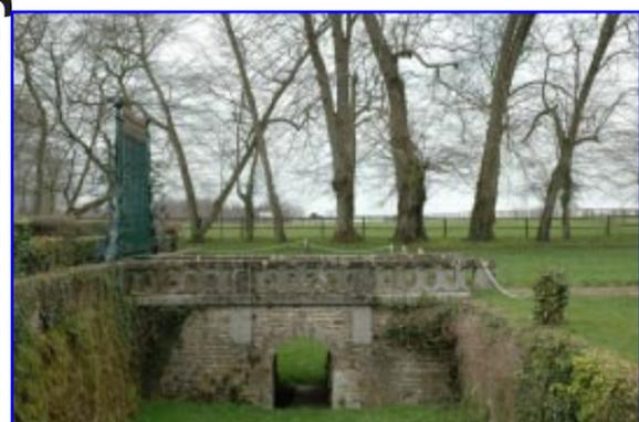
La pierre est utilisée en grande partie pour tout ce qui est construction. Le sous-sol regorge de matière première, ce qui facilite l'édification de nombreux murs... La brique est utilisée de façon ponctuelle, sur les parties hautes des murs (restauration?). Une végétation de lierre, de mousses et lichens vient habiller les murs et apporte aux matériaux la dimension du temps passé.
