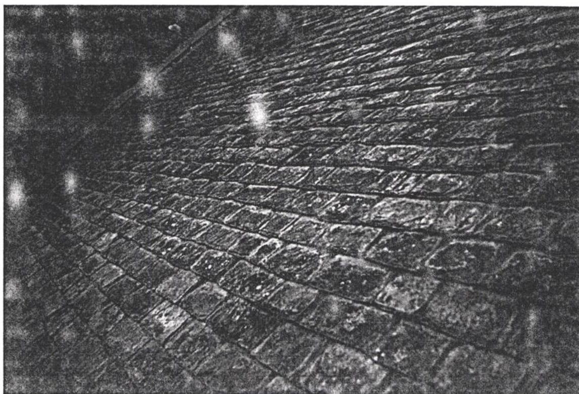
VUE APRES FINITION DES JOINTS
