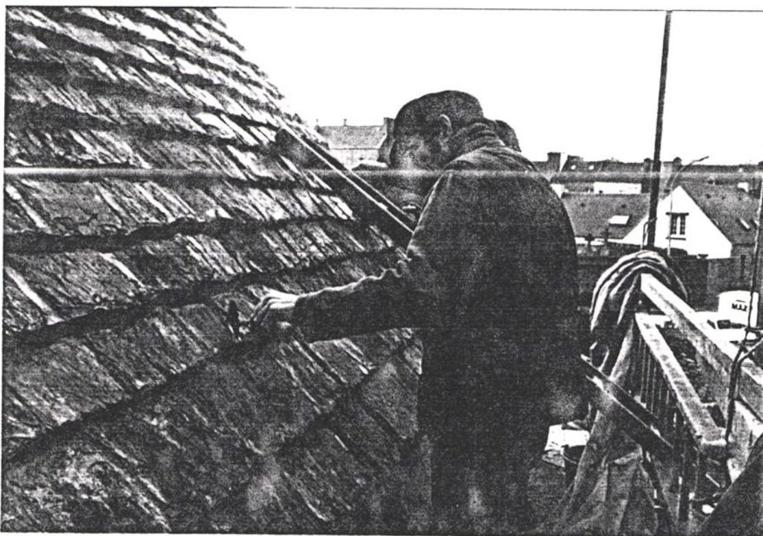
Réfection des joints de la nef
