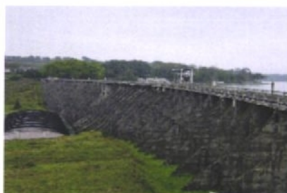
Barrage de Vezins (50)
