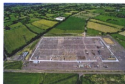
Poste Cotentin-Maine de Taute (50)
