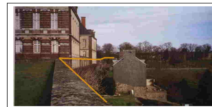
Vue depuis la Cour aux canons
