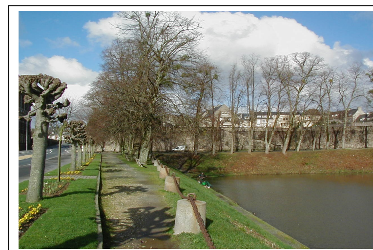
Etat actuel : vue de la RN174 et du talus côté Grand étang
