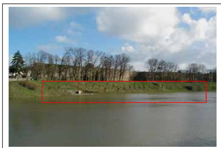
Vue d'une partie du talus : suppression des arbres
