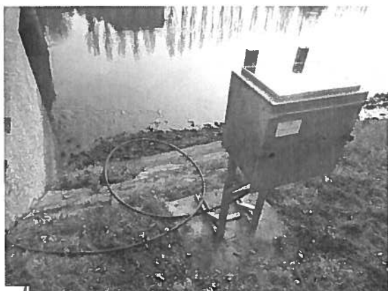
Cabine en cours d'installation le 12/02
