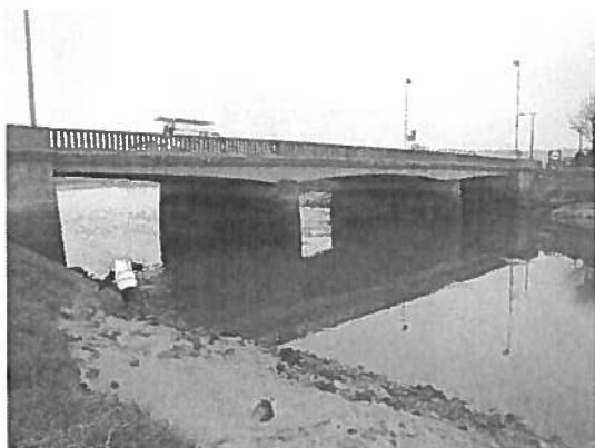
Pont de la RD 513 à marée basse le 12/02
