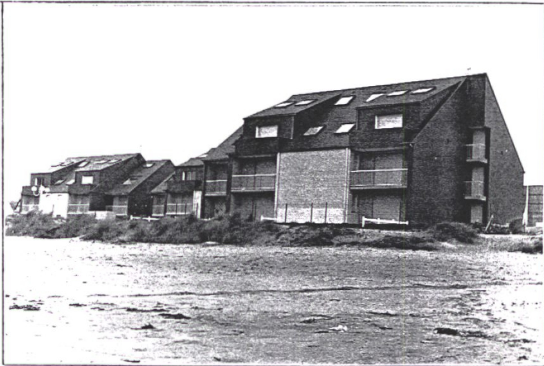
Jullouville (COUTANCAIS-AVRANCHIN) : ces immeubles, construits récemment à moins de 10 mètres du trait de côte, sont potentiellement menacés par l'érosion à court terme.
