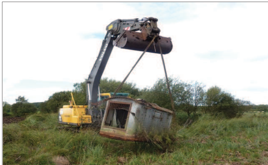
Déplacement à la pelle mécanique du gabion
